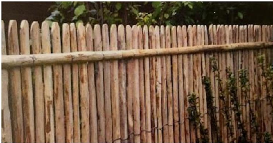
Figure 49 : Clôture en échalas de châtaigner autour du ruisseau (Tecam)
